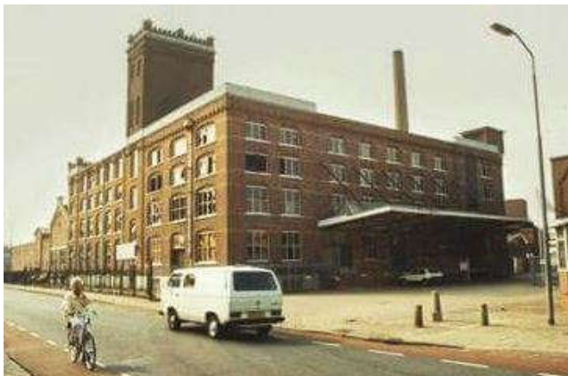
Voormalige jutefabriek Ter Horst - Rijssen
