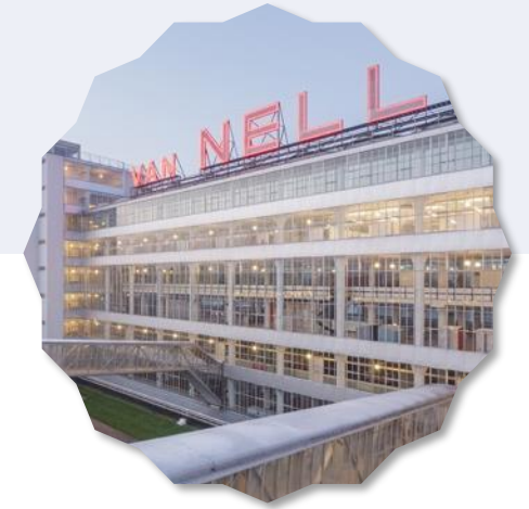
Van Nelle fabriek Rotterdam www.vannellefabriekrotterdam.com
